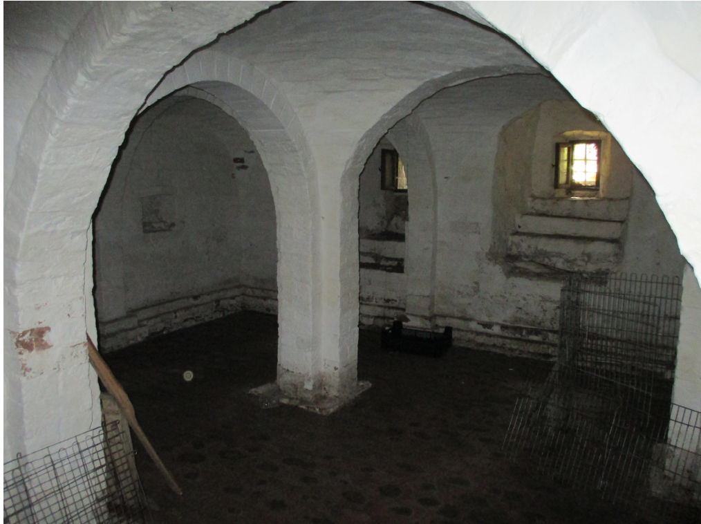
Abb. 10 Kellerraum unterhalb des Chores der Klosterkirche in Börstel. Rechts im Bild ist das nicht ursprüngliche mittlere Südfenster zu sehen.
