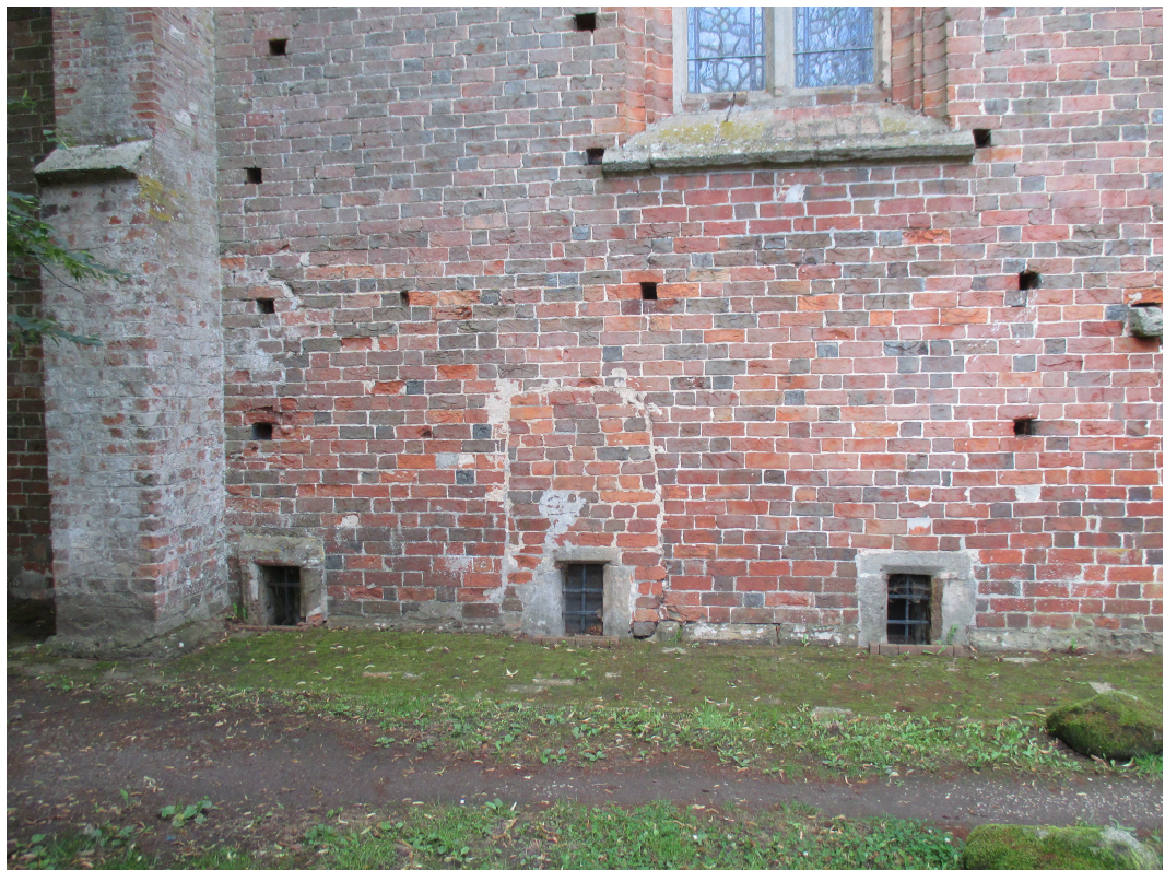
Abb. 11 Die drei Fenster der „Krypta“ auf der Südseite der Klosterkirche in Börstel.
